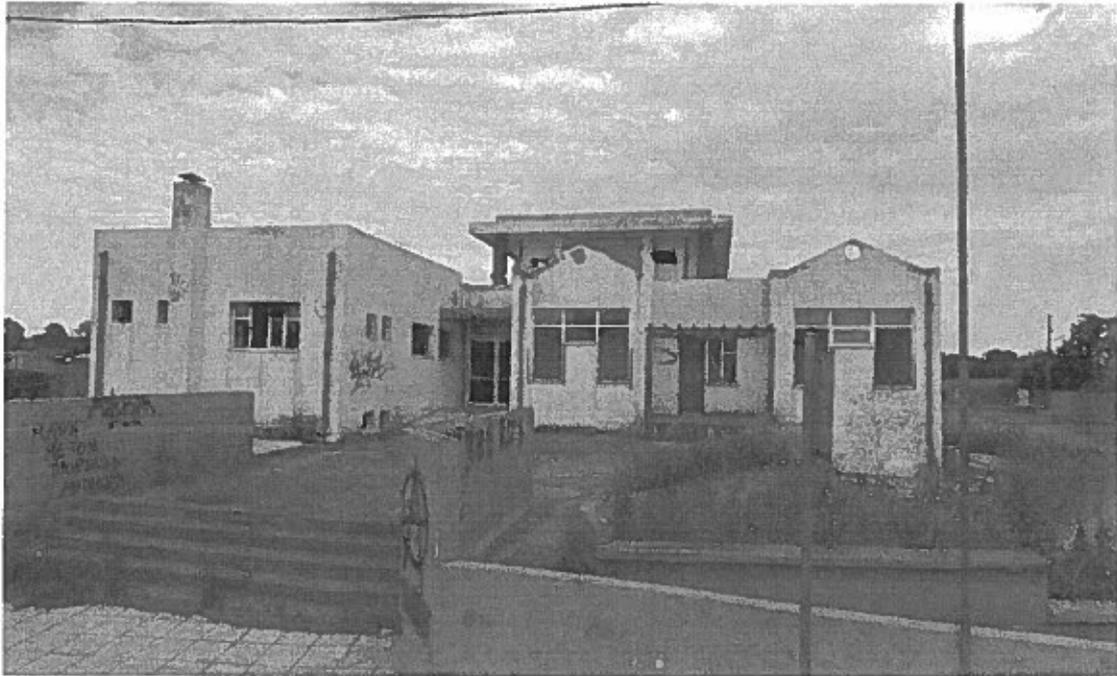
Όλες οι εξωτερικές επιφάνειες του κτιρίου έχουν υποστεί βλάβες λόγω της μη συντήρησης τους καθώς και λόγω βανδαλισμών. Τμήμα των εξωτερικών κουφωμάτων έχει αποξηλωθεί και οι υαλοπίνακες στο σύνολο τους είναι σπασμένοι. Ο περιβάλλον χώρος δεν έχει υλοποιηθεί στο σύνολο του καθώς λείπουν τμήματα επιστρώσεων δαπέδων.
