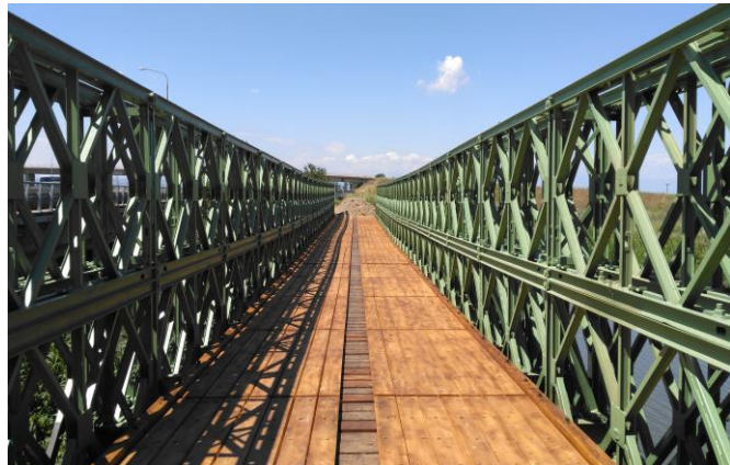
Εικόνα 13 Ν. ΜΑΓΓΑΡΑ Γέφυρα Μπέλλεϋ - Λουδία
