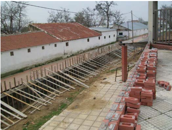
Ολοκληρώνεται η περίφραξη του κολυμβητηρίου
