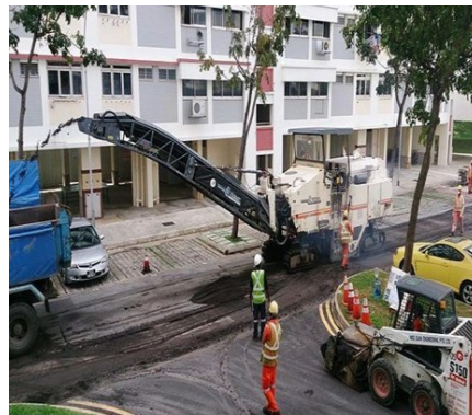
Εικόνα 6. Χάραξη – εκτομή οδοστρώματος
