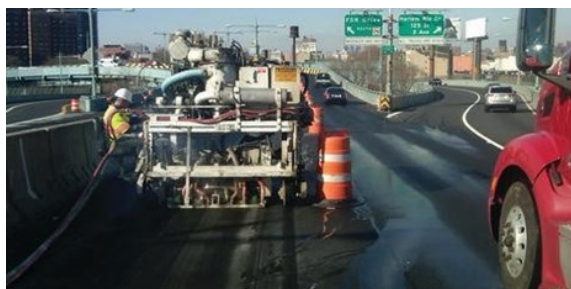
Εικόνα 7. Χάραξη – πριονισμός οδοστρώματος
