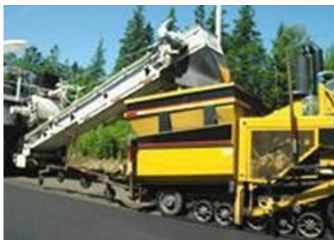
Εικόνα 8. Απόξεση οδοστρώματος
