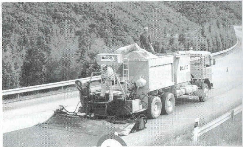
Φωτογραφία 1. Μηχάνημα παραγωγής και διάστρωσης μιγμάτων slurry
